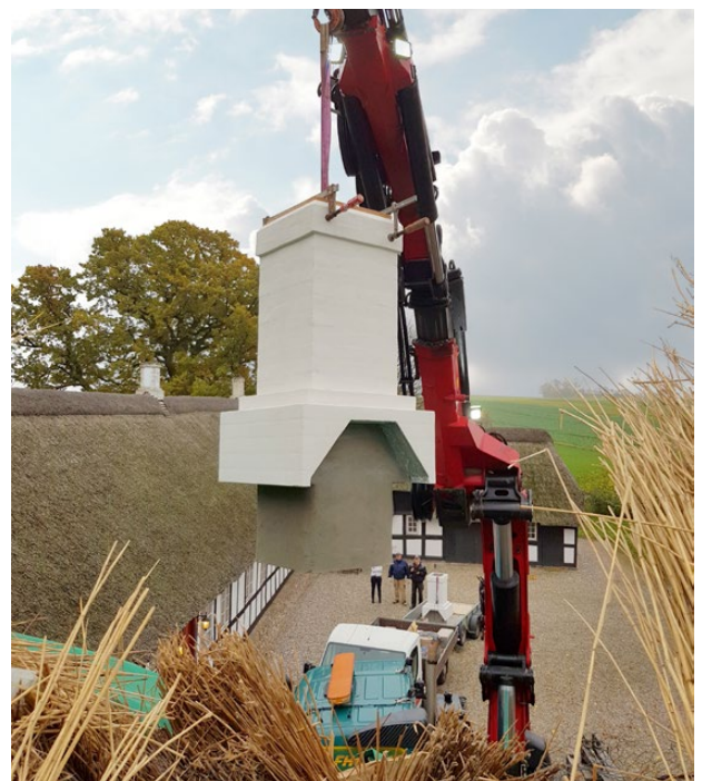
Foto 58 Opsætning af ny skorsten med udkrægning
