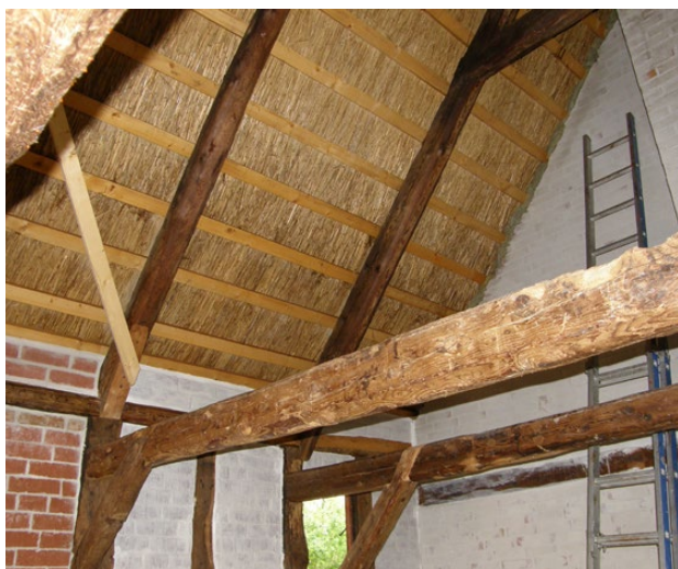
Foto 30 Brolag sikrer en pæn underside
