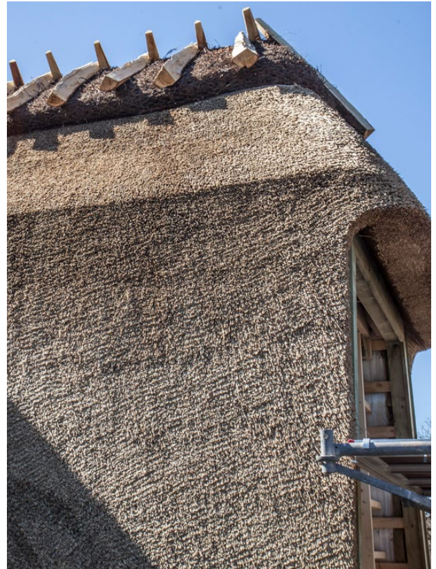
Foto 73 Tækning af mansardtag
