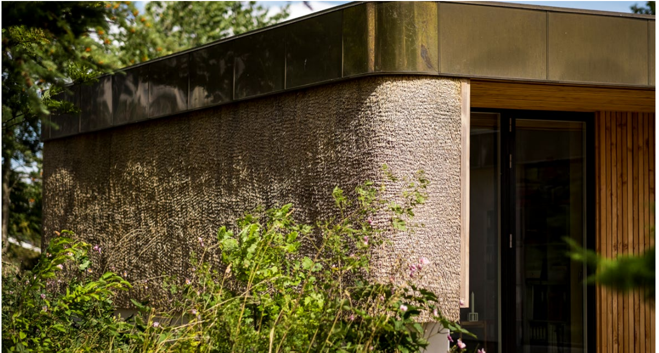
Foto 70 Tækning af lodret facade
