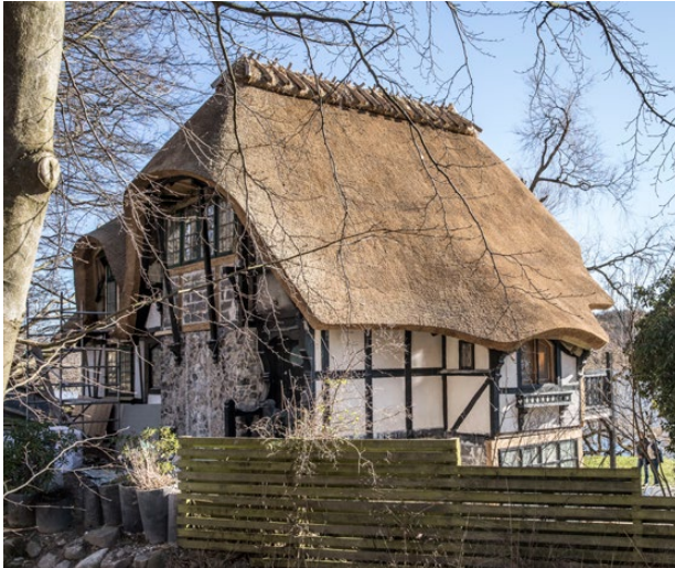
Foto 19 Stort hus – lange rør
