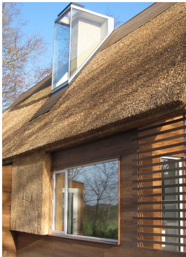
Foto 72 Lodret tækning – Det Åndbare Hus
