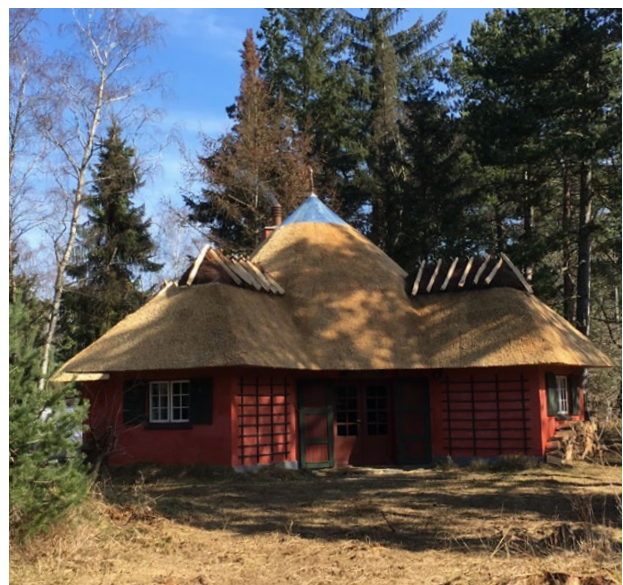
Foto 17 Terrænkategori 3 – bebyggelse med spredte forhindringer
