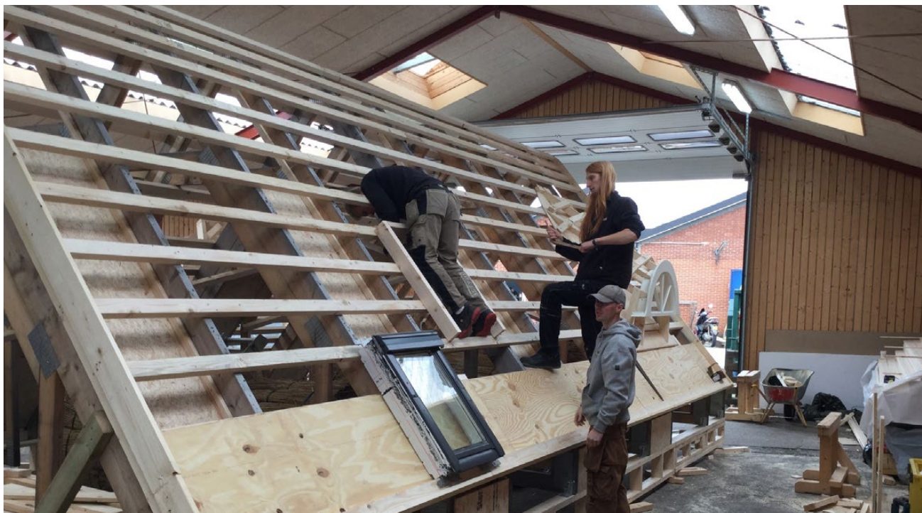
Foto 46 Tagkonstruktion lægget til stråtag
