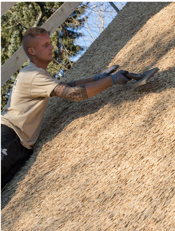
Foto 34 Tagfladen bankes på plads med en tækkeskovl
