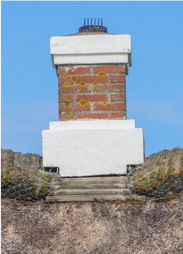
Foto 56 Skorsten med muret udkrægning
