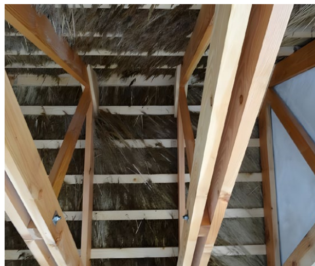
Foto 31 Uden brolag får man en "floffy" underside, der drysser
