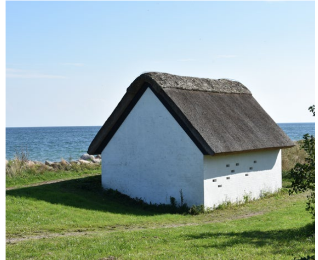
Foto 20 Lille hus – korte rør
