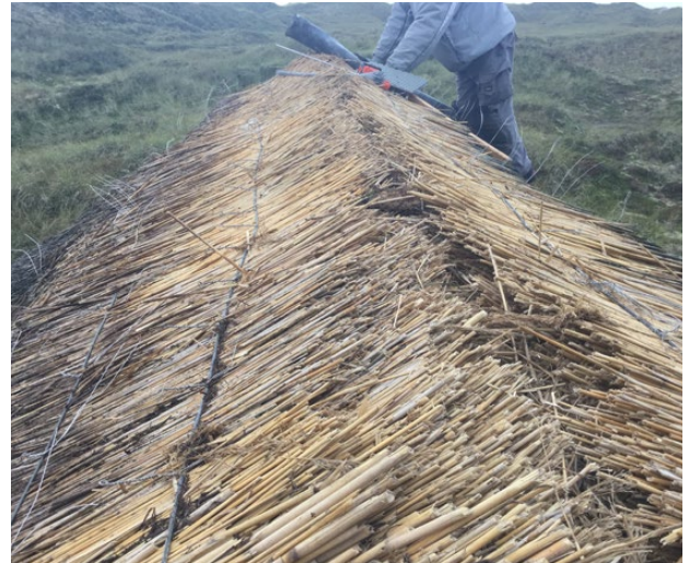
Foto 33 Rygning, der er klippet
