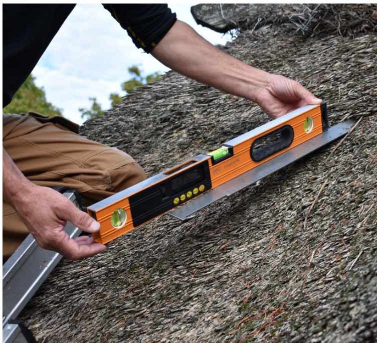
Foto 9 Måling af rørenes hældning
