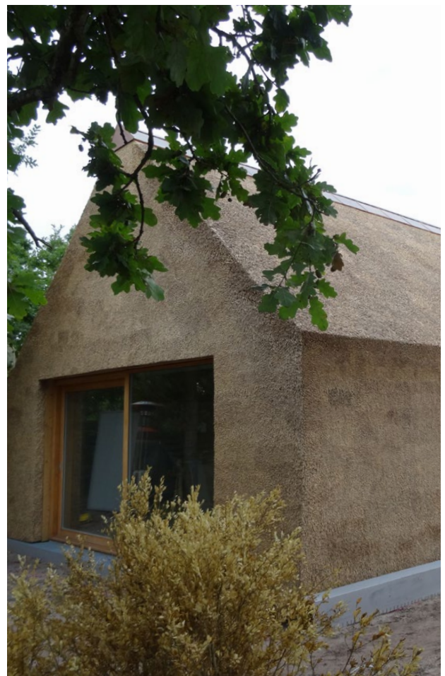
Foto 2 Tag og facade tækket ud i et
