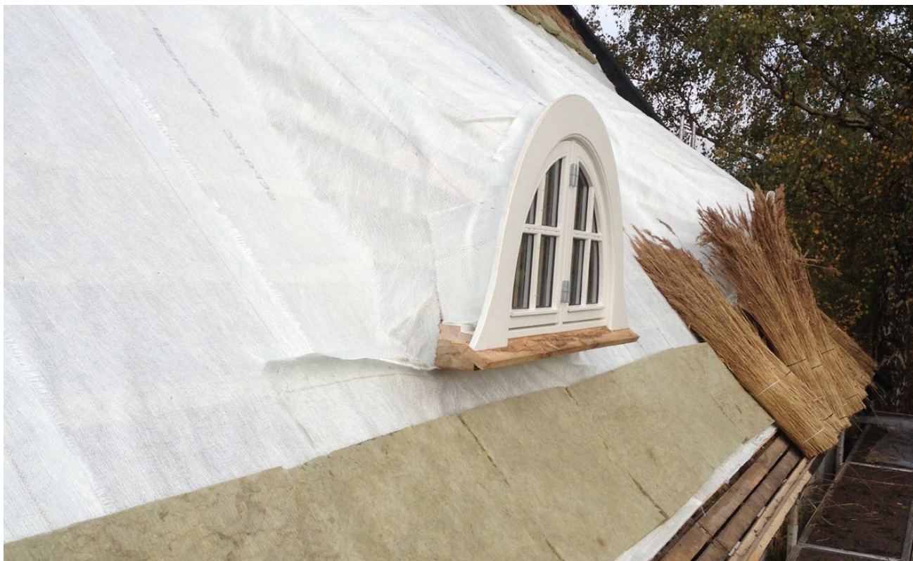
Foto 6 Eksempel på brandhæmmende glasfiberdug (ikke brandsikret stråtag i henhold til bygningsreglementets præ-accepterede løsninger)
