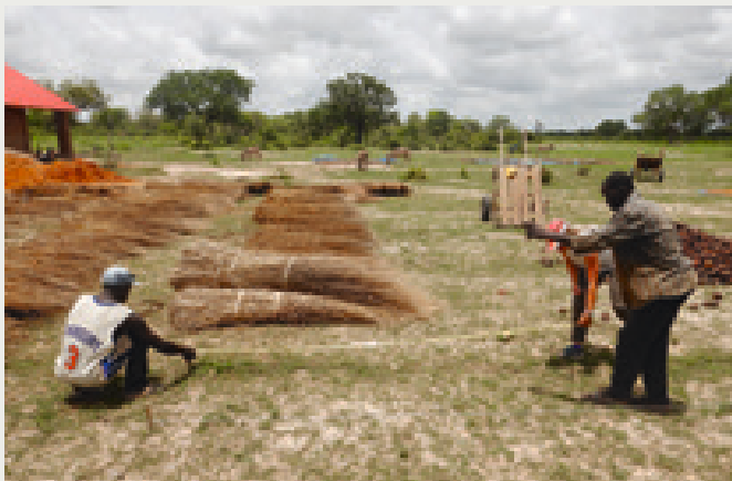
Opstartsfasen omfattede målsætning af bygningen på grunden, udgravning og at skaffe byggematerialer. Sten til fundamentet blev hentet ved håndkraft i bushen og kørt tilbage til site med æseltrukne vogne. Tækkerørene blev købt af lokale og blev lagt til tørre, pga. uhensigtsmæssig opbevaring.
