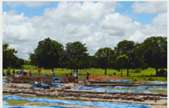
Mens fundamentet tørrede, begyndte vi at lave "adobe-mursten". De blev lavet af jord, strå og vand og presset i form og lagt ud på jorden for at lufttørre.
