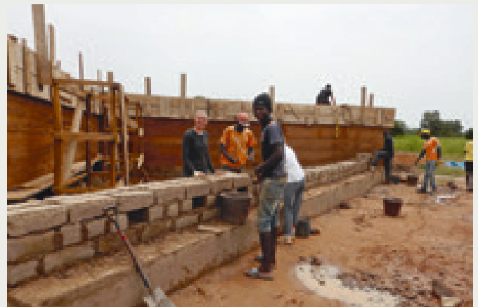
Da fundamentet var tørt begyndte vi opbygningen af væggene i stampet jord, og konstruktionen af nordsiden med adobe sten. Hullerne i væggen er designet til at give bedre luftgennemstrømning og lade lys komme ind.
