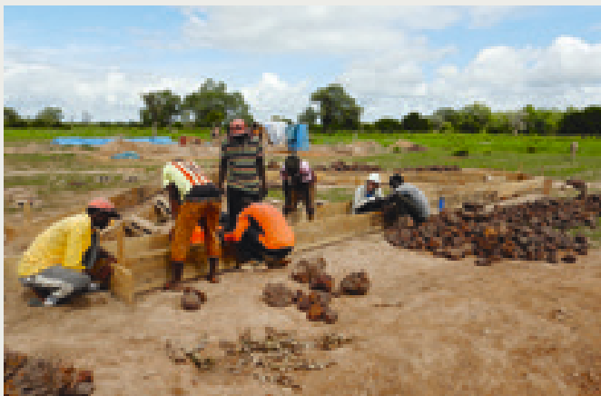
Fundamentet begynder langsomt at tage form. Det blev lavet af sten af forskellige størrelser i en mørtel af jord og ler, kaldet "poto poto". Fundamentet blev lavet til bænk højde, støbt i en træramme og afsluttet med det mere holdbare kalkmørtel.
