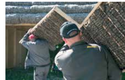
Elementerne er fragtet fra Stege til Læsø, og Det moderne Tanghus er samlet på stedet. Huset er dermed præfabrikeret for at holde prisen nede.
