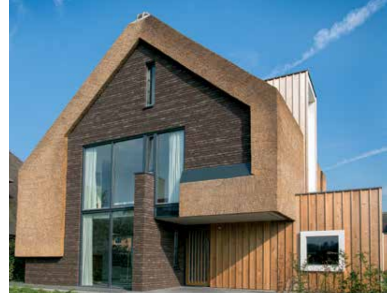
Et eksempel på, at taget folder sig ned og bliver til lodret facade.
