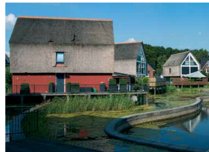
Husene ved det nyfortolkede gadekær i Nunspeet. stråtagene fortsætter som facader ned på langsiderne og afsluttes lige over hoveddørene.
