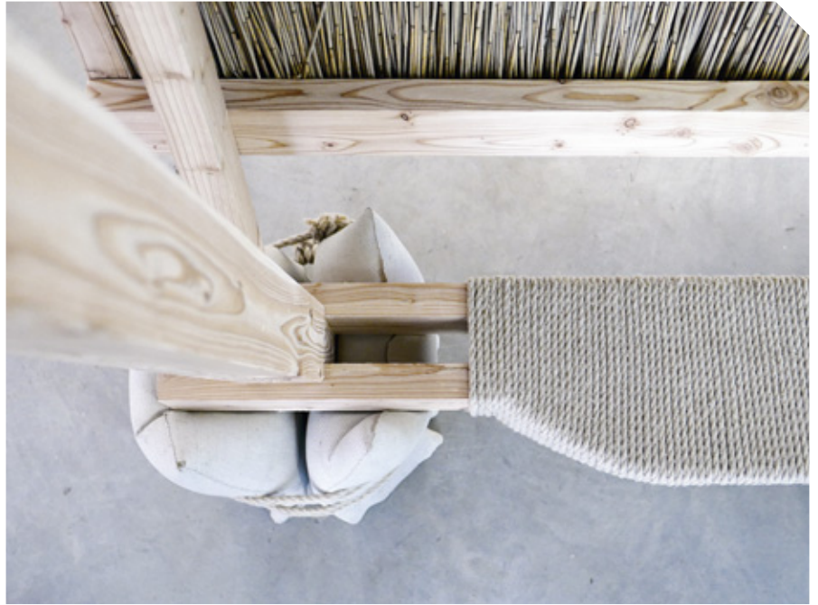
Detalje set fra oven af fundament, fodrem og bænk surret med hampreb
