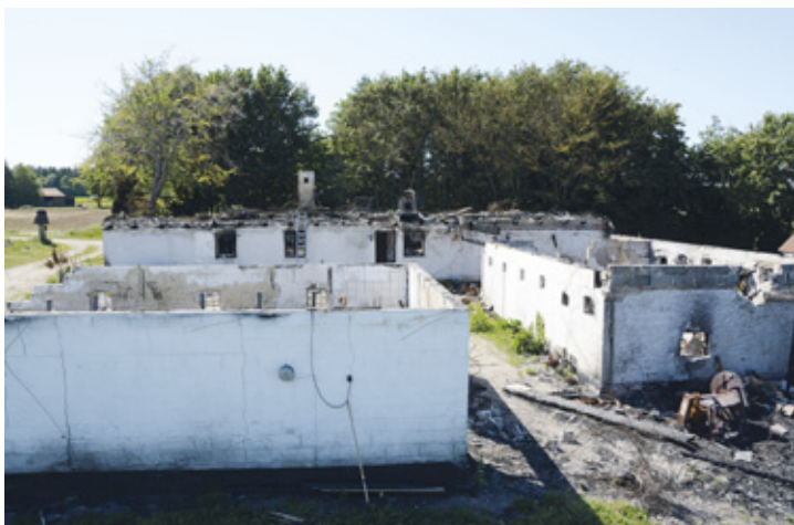
Sådan ser den trelænggede ejendom ud i dag. Peter B. Nielsen er ikke i tvivl om, at der skal et brandsikret stråtag på det nye stuehus.
