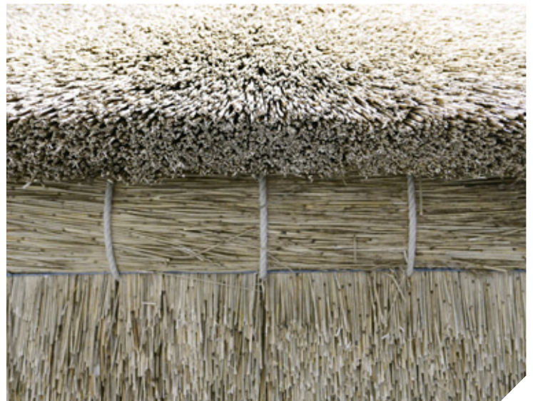
Detalje af den noget 'spidsvinklede' mansard-overgang fra tag til væg, der blev imødekommet med en bred og beskyttende rulle af tagrør syet på med hampreb og brugt som opspænd for tagrør og -skæg ovenfor
