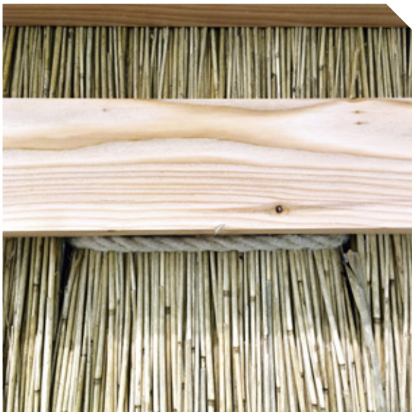
Detalje af indersiden af fastgørelsen med hampreb af den ydre beskyttelse og opspænd af tagrør der introducerer et mønster i strølaget og en form for ornamentik på bænken 'ryglæn'
