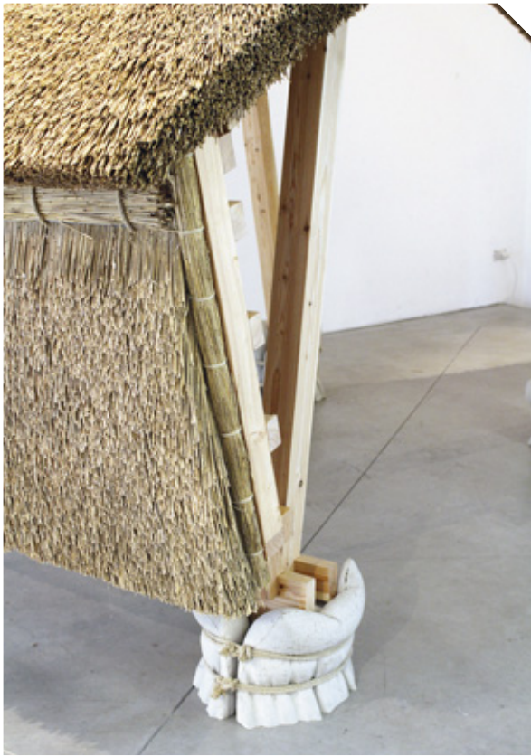
Detalje af pavillonens vægder hvor man som kompliment til tagets jyske vindskeder har introduceret en alternativ sjællandsk en af slagsen opbygget langs en lægte og en bundet 'pølse' i tagrør
