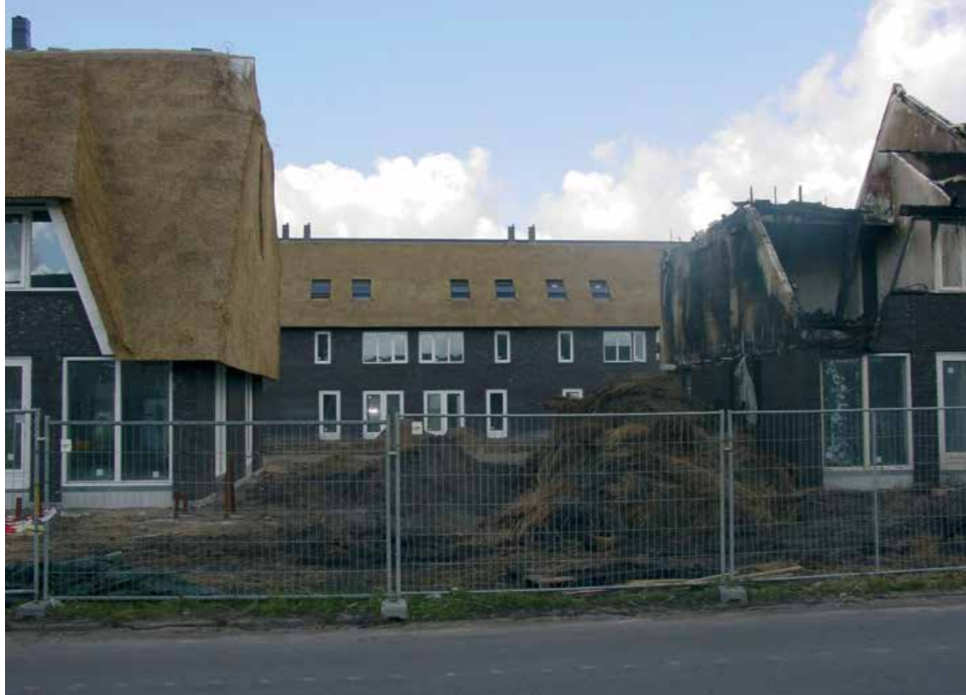
Alt kan brænde, selv Nordsømuseumet brændte, selv om det består af beton, stål og akvarier. Her er det et stråttækket hus i Holland, der er brændt – det bemærkelsesværdige er, at huset ved siden af – på 6 meters afstand – hverken er antændt eller afsvedet.
