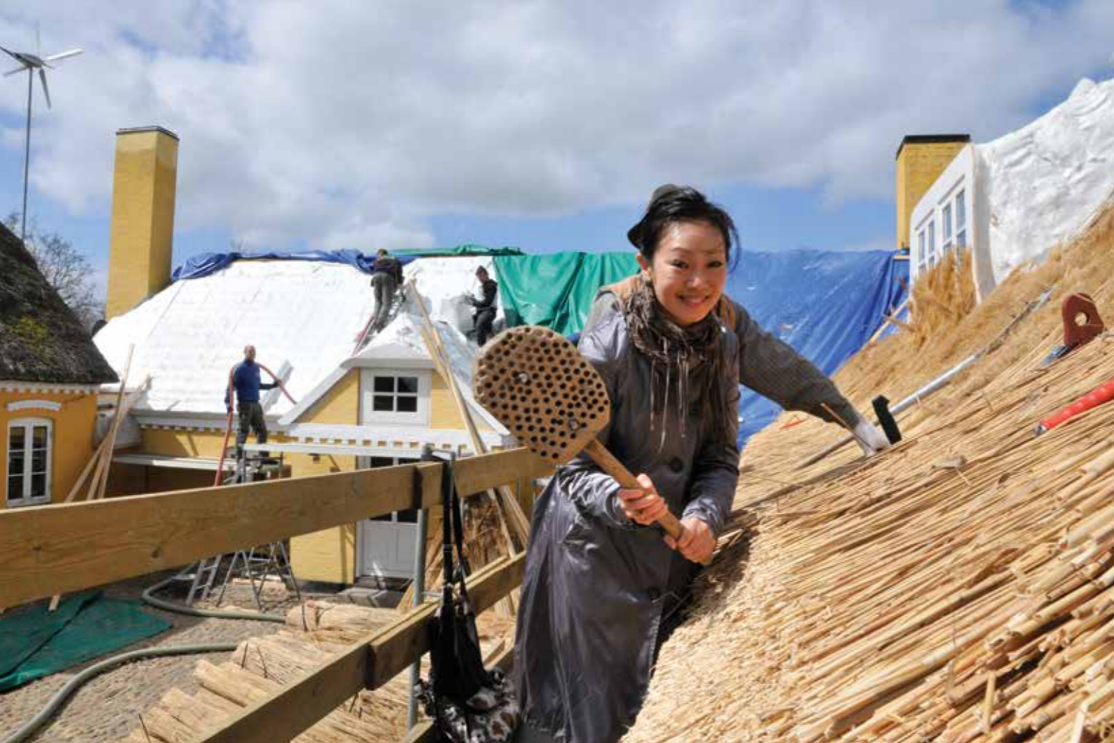
Akios veninde, Yoki, i lære som tækkekvind hos Kim Hansen på Fyn. Her blev brandsikret og varmesolert samtidig, og indpustning af papiruld bag Sepatec'en påkaldte sig en del opmærksomhed fra japansk side.
