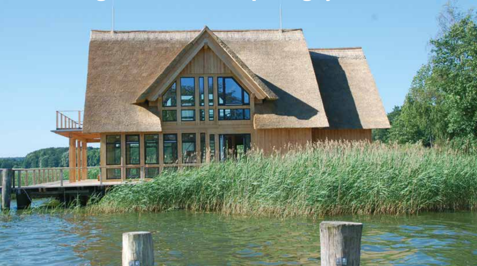
Der tækkes også nye huse i Tyskland, hovedsageligt ferie- og fritidshuse. Byggefirmaet NCC har opført en række "typehuse" med stråtag i delstaten Mecklenburg-Vorpommern.
