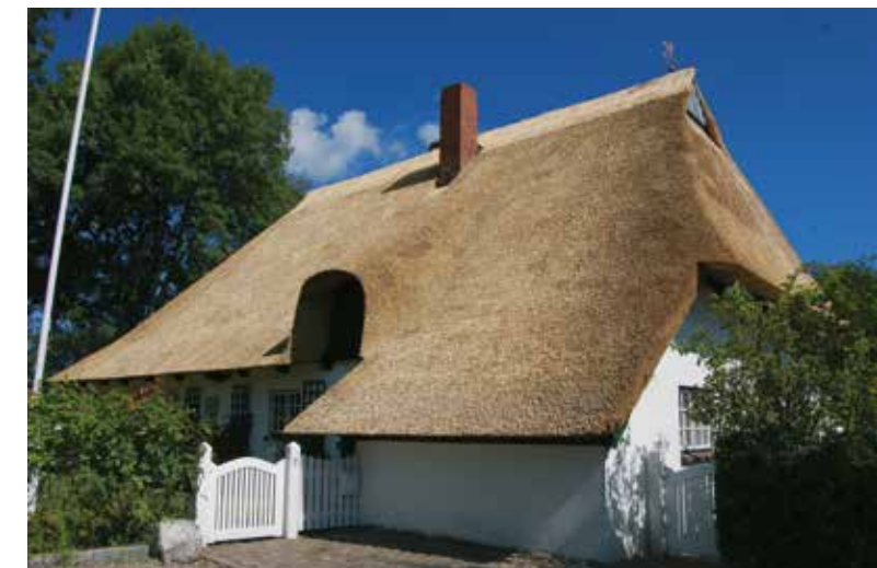
Typisk nordtysk hus med syet rygning
