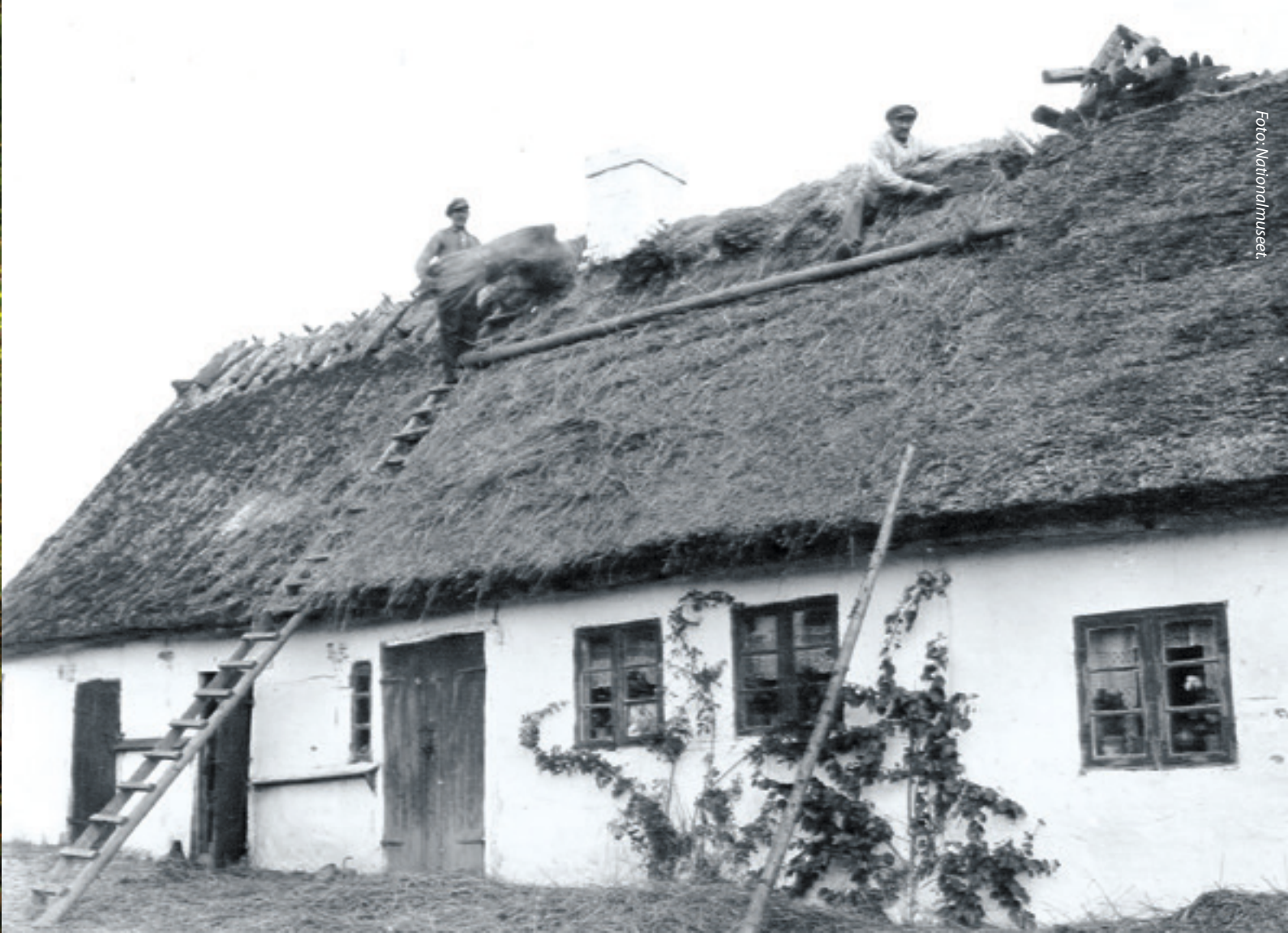
↑ Tækkemænd i gang med at lægge den typiske sjællandske rygning – også kaldet mønning – holdt fast med kragetræer, oftest udført af flækket egetømmer. Foto fra 1925 af hus i Kundby ved Holbæk. Foto: Nationalmuseet
