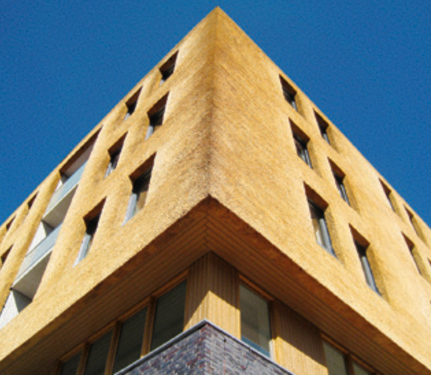
En tækket facade på et plejehjem i Holland.
