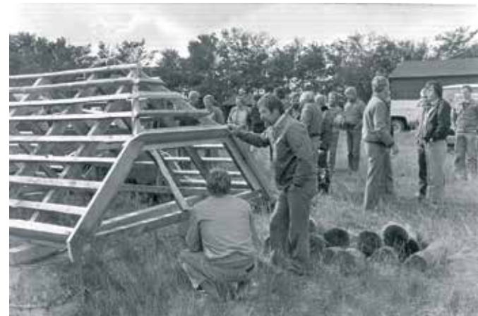
Foto fra bindedagen i 1985, da tækkemester Jens Greve fra Mariager præsenterede en revolutionerende opfindelse: Tækkeskruen. I begyndelsen sad både Erling Bach Pedersen og Jens Greve derhjemme om aftenen og vikled ståltråd på skruer. "Man fik s'gu omme fingre af det", siger Erling, der var et år om at udvikle en maskine til at fremstille Tækkeskruen med.
