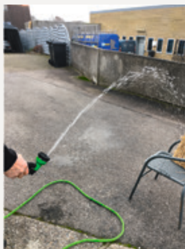
Test af vandtæthed
