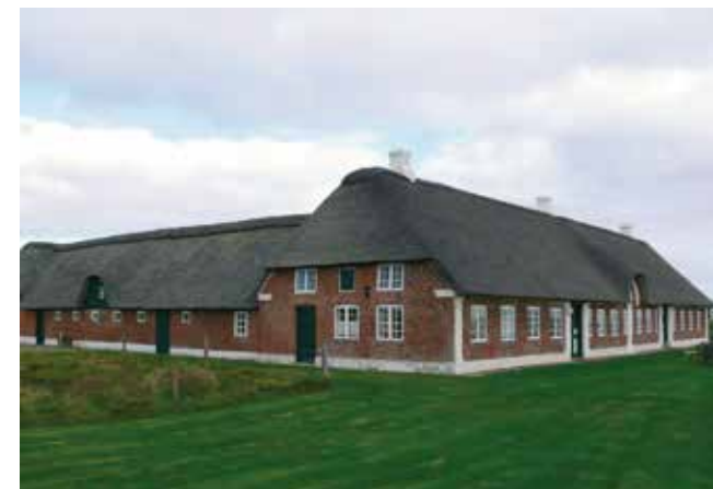
Abelines gård her på billedet er en typisk klitgård, som Jens Holst har taget udgangspunkt i og herefter genfortolket den vestjyske byggeskik og omsat den til et nutidigt bud på en klitgård.
