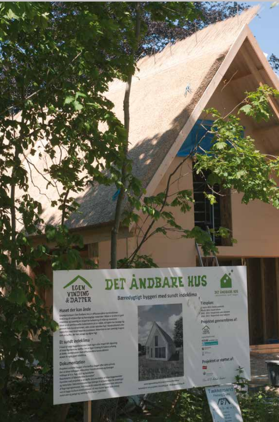
Sådan så Det Åndbare Hus ud midt i juni måned, da der var tækket næsten i top. Det bliver indviet sidst i august, hvorefter der skal måles fugtgennemstrømning 40 steder i huset gennem et år. (Foto: Martin Vollmer)
