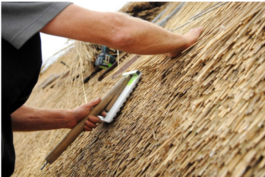
Figur 1 - Stråtag under opbygning
