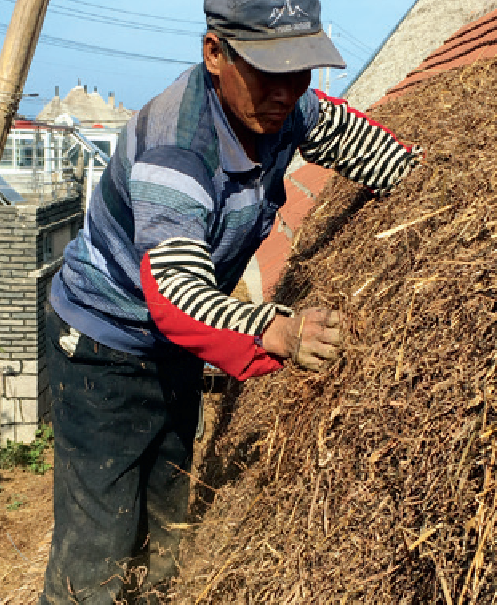
Denne ældre mand (t.v.) forsøgte at lære Læsøs tængemand, Henning Johansen at rede ålegræs, for det er sirligt rettet til, så stråene har samme retning, inden det lægges på taget. >
