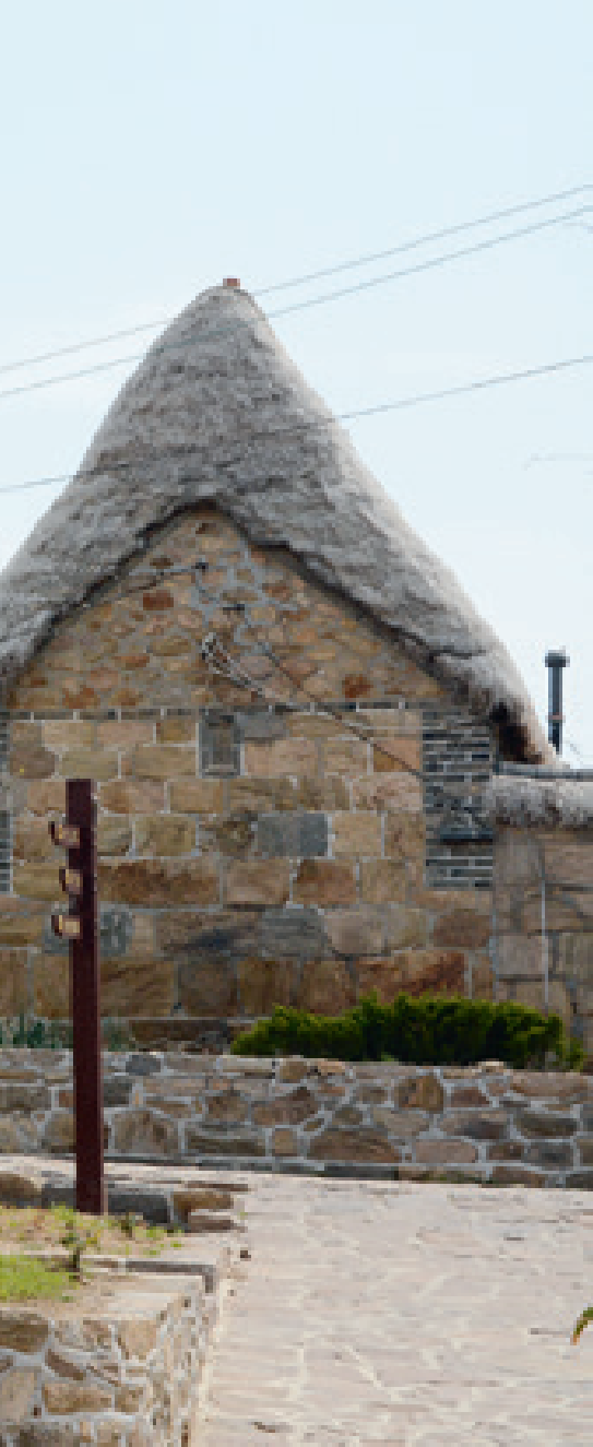
Både tagsten nederst og første "bind" af ålegræs lægges i vådt ler uden yderligere fastgørelse.
