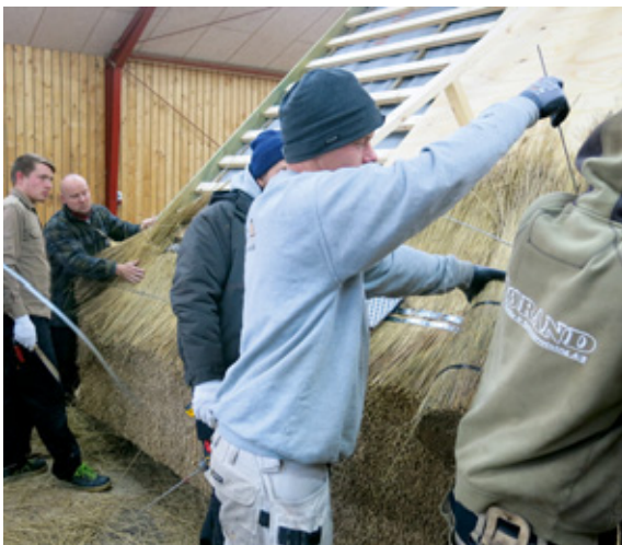
Her tækker elever det prøvehuse, som i nu to år har stået i Hadsten. Teknologisk Institut har gennem to vintre målet stråtagets isoleringsevne i dette prøvehuse som en del af Test-projektet.
