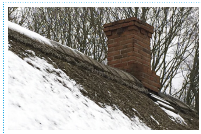
Nærbillede af Tang-Tørvene som mønning på det stråttækte hus i Feldballe ved workshoppen. Mønningen har fået en lys hvidliggrå nuance, som også kendes fra Læsøtangtagene, og matcher stråttættet nydeligt.
