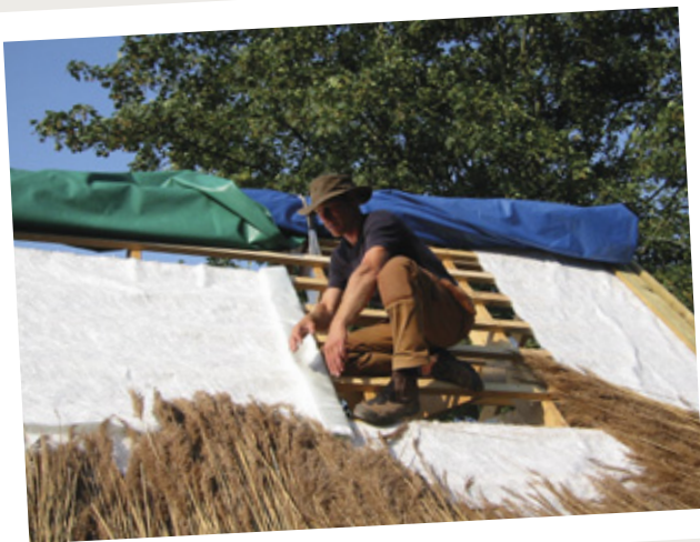
Ruud Conijn er her i gang med at tække det første tag, der blev brandsikret med Sepatec.
