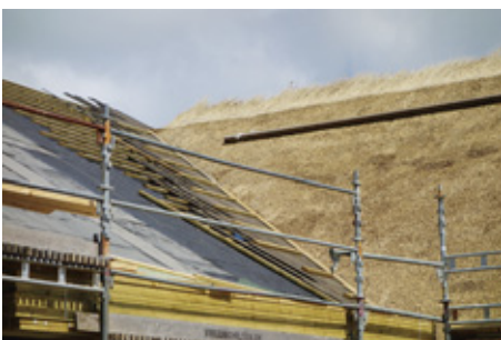
◀ Nogle tagflader har for lille hældning og derfor blev stråtag droppet her. I stedet er der fast undertag, som dækkes med træbeklædning. Denne løsning bruges også på nogle af de oprindelige facader.
