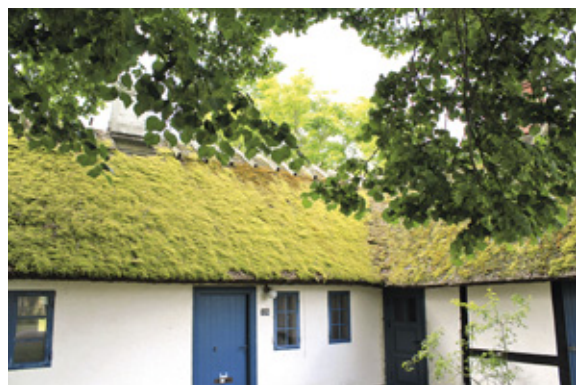
Tækket 1998, masser af mos, hus på Enghavevej, Frejlev. Tag i orden.
