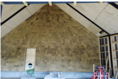
◀ Gavlen i det overdækkede publikumsområde er ligeledes tækket med strå, her bliver det svært at holde pilfingrene i en meters afstand.
