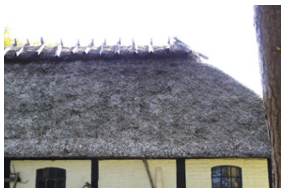
Nysted Skov, tækket af Søren Vodder 1980, danske saltvandsrør. Der har været mos på i 30 år, uden at det har betydning for tagets levetid.
