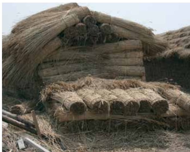
Et eksempel på, hvordan der er lavet "tag" over tagrørstakken for at undgå vand og sne ned gennem bunken.
