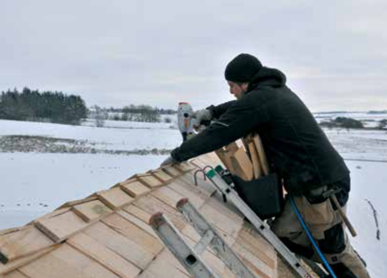
Rygningen er helt usædvanlig og så vidt vides aldrig set før i Danmark: Egespåner på klink, lagt af husets ejer, Niels Meyer, der også er tømrer.
