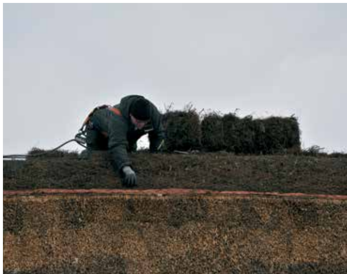
Der er syet med kobbertråd og lagt en tyk kobberstang under trådvævet, som også er af kobber – alt sammen for at forebygge alge- og mosdannelse.
