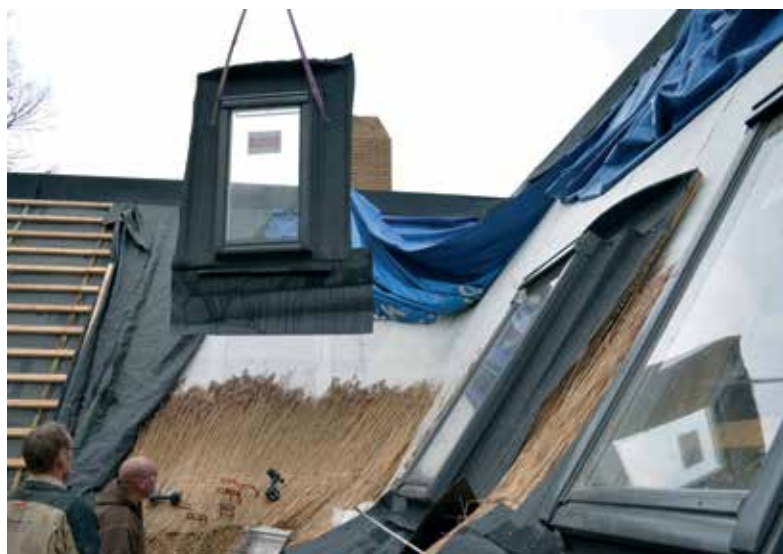
Der kommer masser af lys ind i den nye tilbygning, som rummer 625 etagemeter, ovenlys, kvist og 14 Velux-vinduer.
