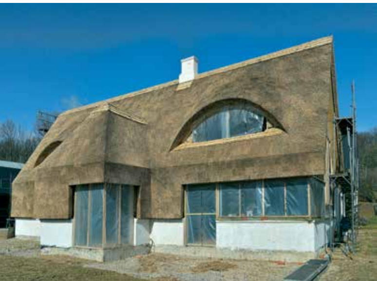
En rygning af træspåner er sandsynligvis en løsning, der holder i rigtig mange år – måske lige så længe som taget.
